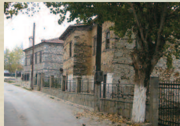
Παραδοσιακά λιθόκτιστα κτίρια στόν κεντρικό δρόμο που οδηγεί στήν κεντρική πλατεία «Τά Πλατάνια» του Λειβαδίου.
